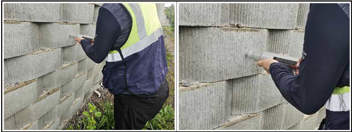
【그림 9.3.6】 슈미트해머를 이용한 반발경도시험 전경
